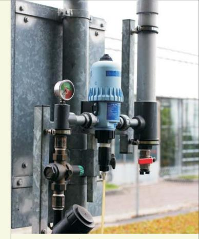
mengenproportionale Dosierung (Filter/Druckminderer/Manometer/ Dosiereinrichtung/Mischkammer)
