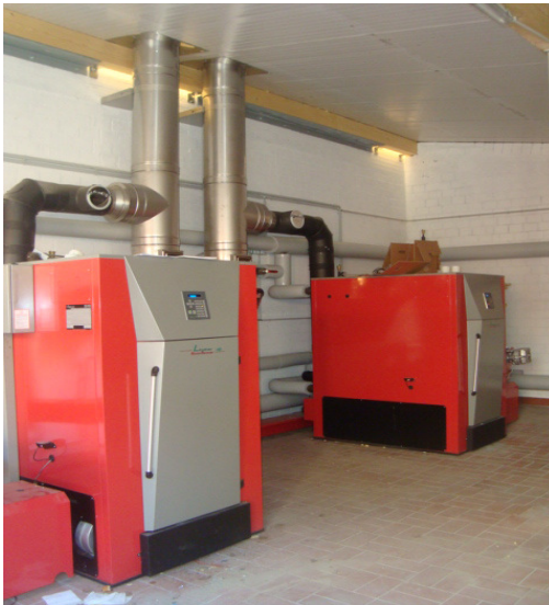
Die 2 x 150 kW Holzfeuerungsanlagen mit 3 x 2.000 l Pufferspeicher
