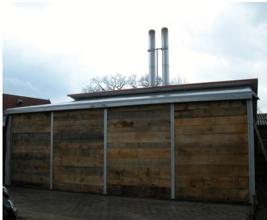
Das flexible Hackschnitzel-Vorratslager ist direkt an den Feuerungsraum angeschlossen
